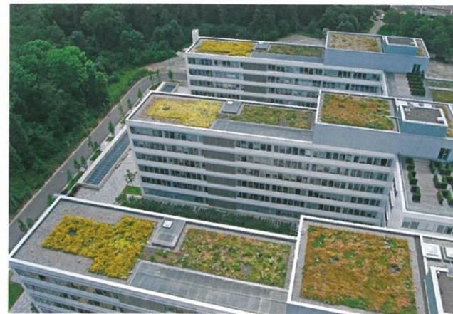
Unterschiedliche Extensivbegrünungen und Windsogsicherungen bei den drei Riegeln.
